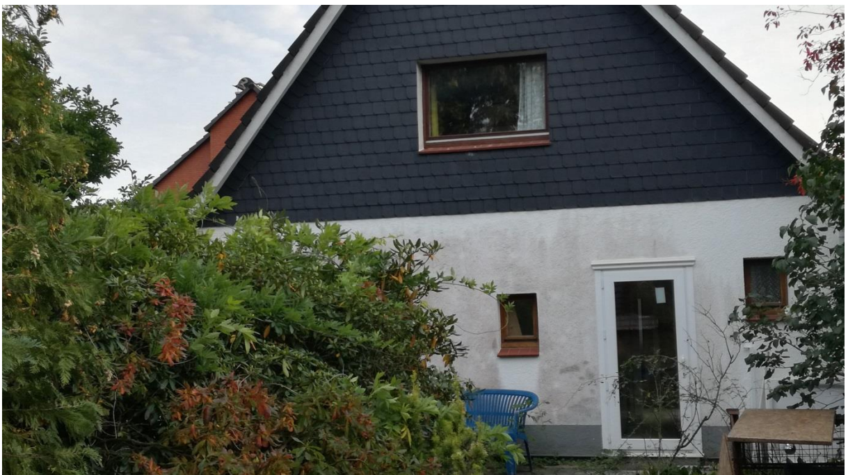
Gebäude südlich im Geltungsbereich
