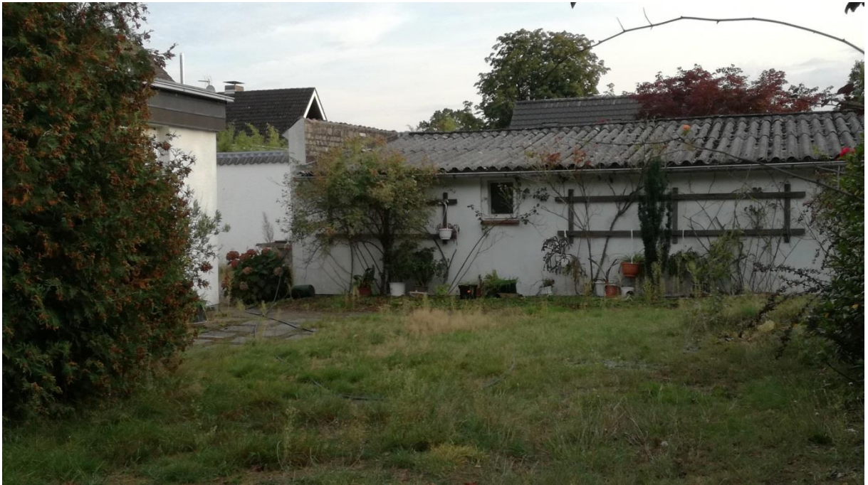
Südliches Gebäude im Geltungsbereich, keine direkte Betroffenheit
